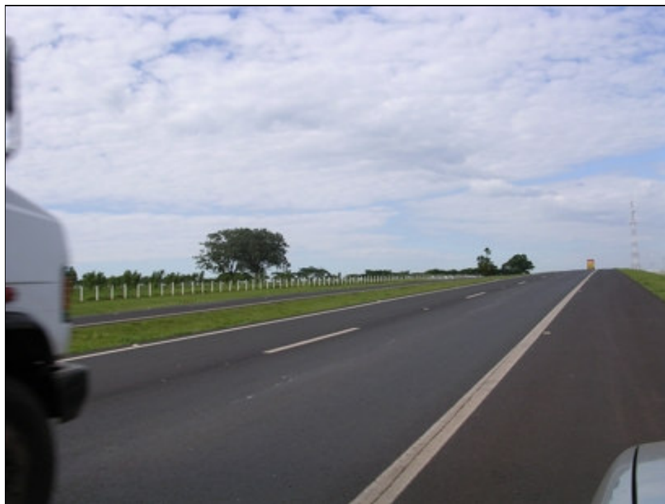
Figura 21: Vista da pista Sul da SP255 na altura do km 32, com o aspecto típico da rodovia de pista dupla, com canteiro central e vegetação herbácea podada na área de refúgio.
