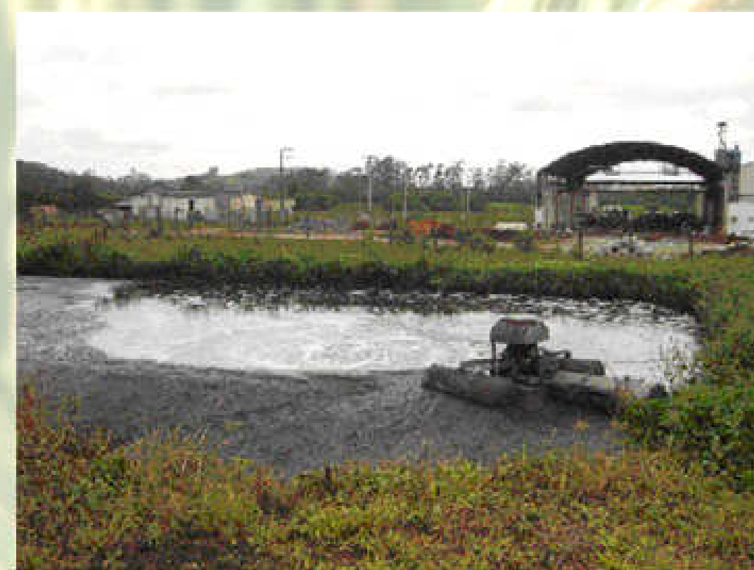
Lagoa de armazenagem da água utilizada no transporte da CCA
