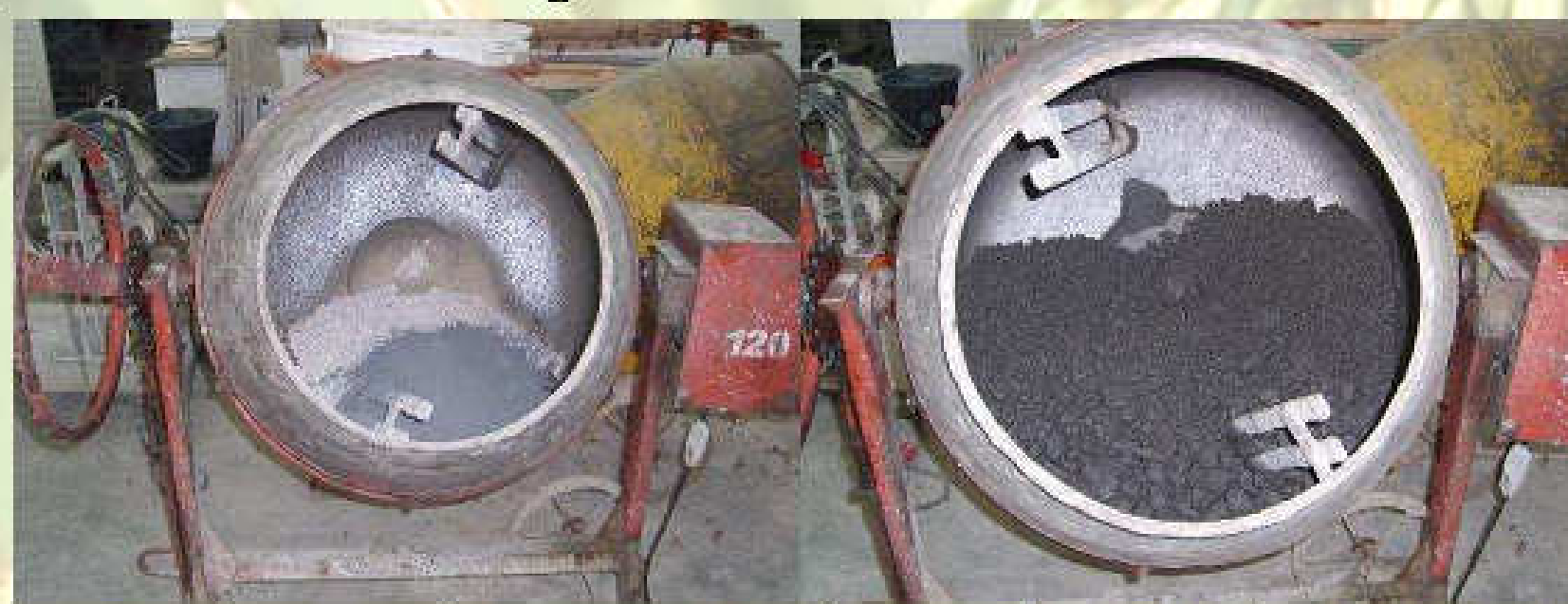
Agregados secos na betoneira e mistura homogênea
