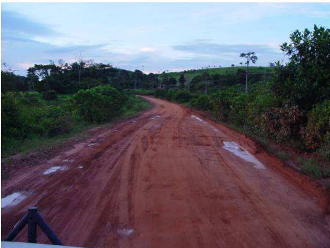
Figura 108 - Revestimento primário em arenito. Região de transição geológica do granito para arenito e siltitos.
