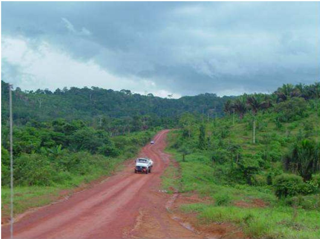
. Figura 183 - Segmento com boa capacidade de suporte. Revestimento em cascalho em cascalho laterítico. Km 272. 56°8'37" O – 4°50'31" S.
