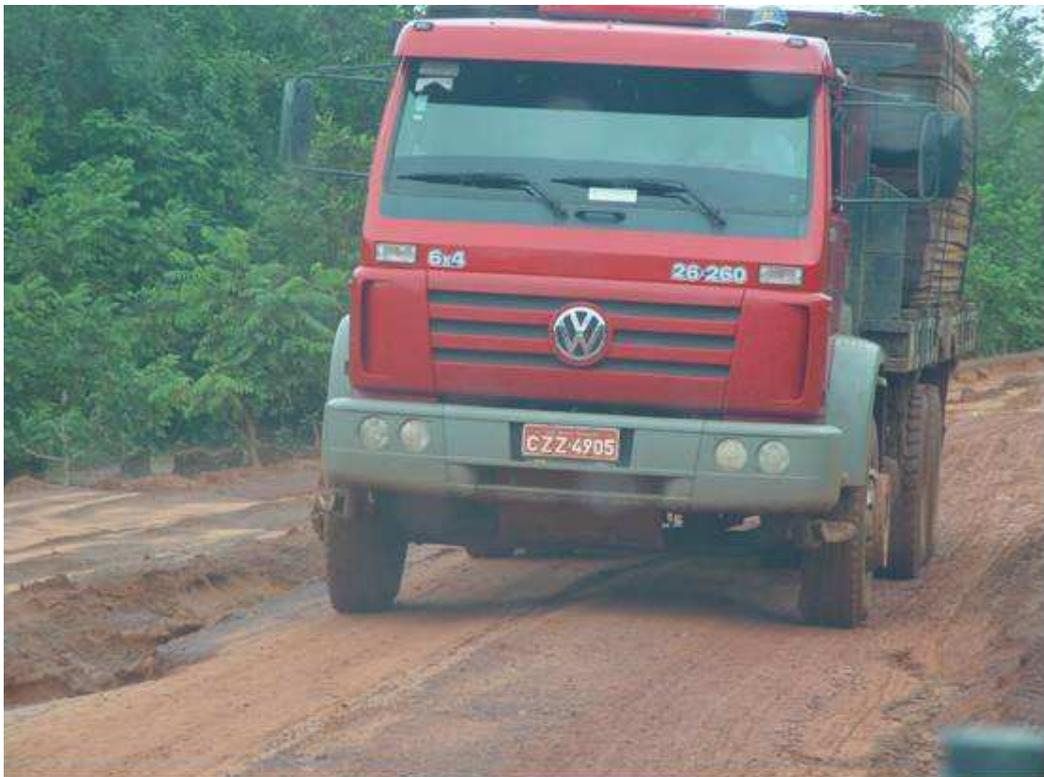
Figura 47 - Início dos processos erosivos. Solo arenoso sedimentar aluvionar (paleoterraço). Aterro em solo laterítico. Revestimento primário de pequena espessura em cascalho laterítico.
