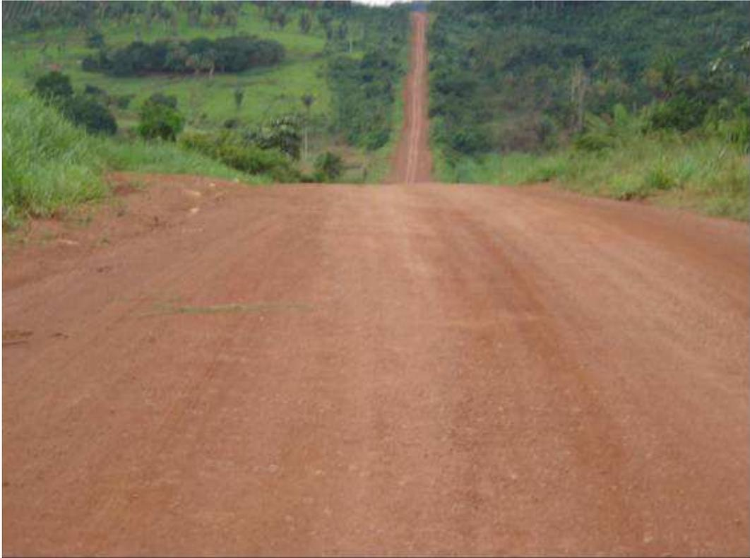
Figura 182 - Plataforma e boas condições de rolamento. Greide colado no horizonte B. Horizonte B de pouca espessura. Revestimento primário em cascalho laterítico.
