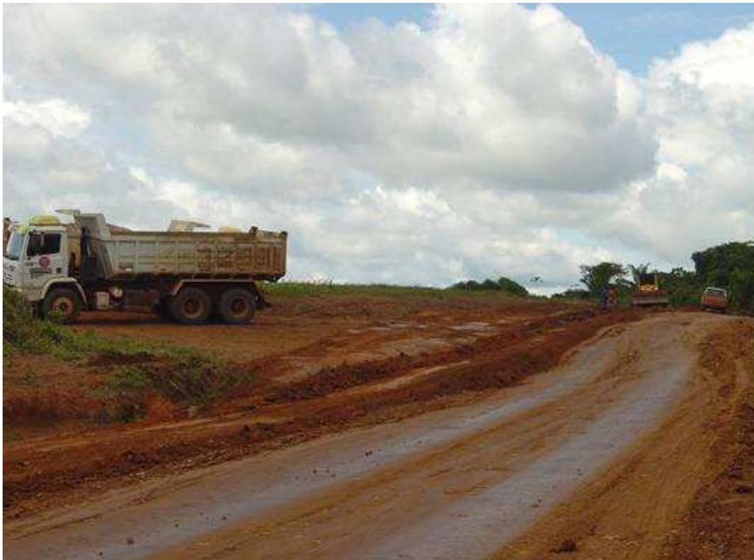
Figura 105 - Segmento em manutenção. Recarga do revestimento primário.
