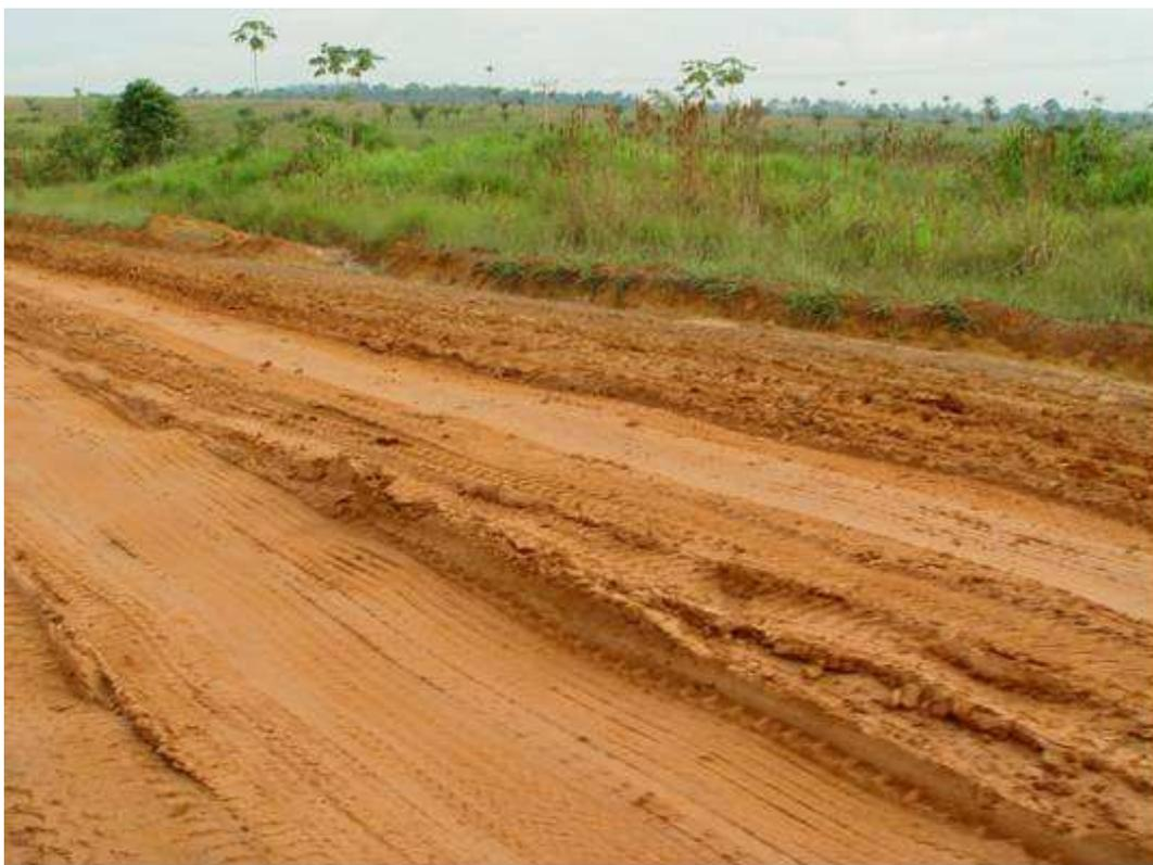
Figura 128 - Camada final de terraplenagem solo muito argiloso. Borrachudos. Revestimento primário contaminado pelo solo. Km 30,1.  $55^{\circ}29'33''$  O –  $6^{\circ}40'49''$  S
