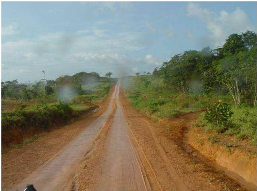
Figura 103 - Segmento em boas condições de rolamento. Greide da rodovia na transição do horizonte B para o C. Revestimento primário de pequena espessura em cascalho laterítico.
