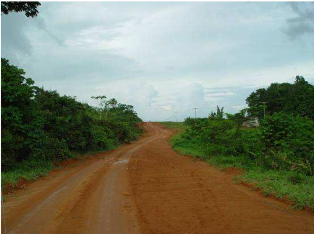
Figura 181 - Plataforma em boas condições de rolamento. Greide colado no horizonte B.
